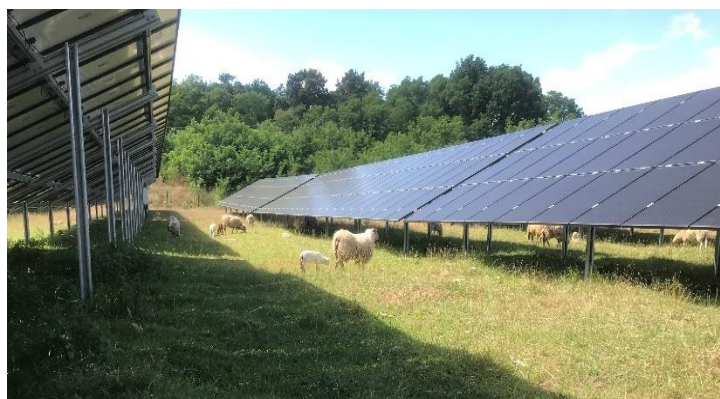
Abbildung 6: Extensive Schafbeweidung im Solarpark
