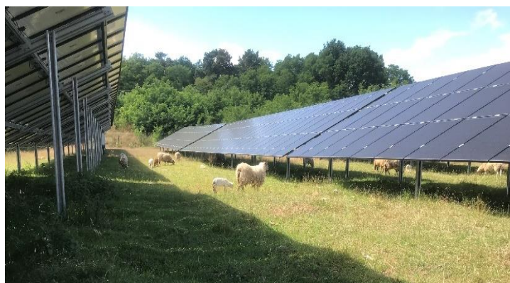
Abbildung 6: Extensive Schafbeweidung im Solarpark
