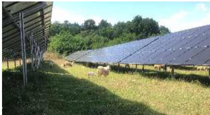
Abbildung 6: Extensive Schafbeweidung im Solarpark
