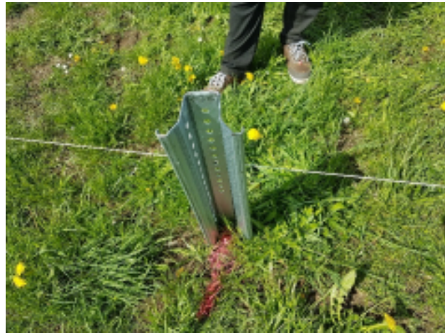
Abbildung 8: Rammfundament
