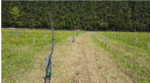
Abbildung 6: Verfüllter Kabelgraben
