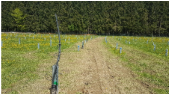
Abbildung 3: Verfüllter Kabelgraben
