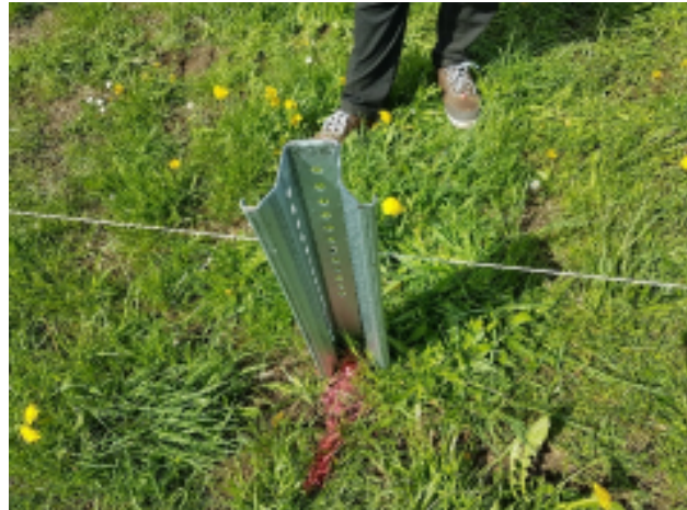
Abbildung 5: Rammfundament
