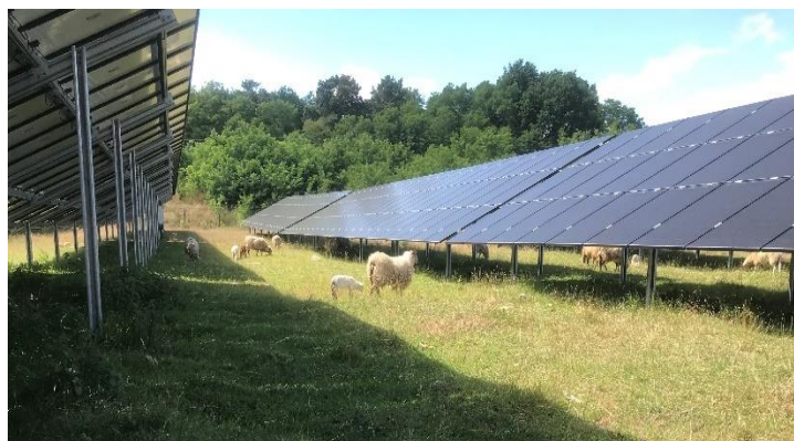
Abbildung 6: Extensive Schafbeweidung im Solarpark
