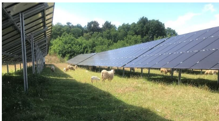
Abbildung 6: Extensive Schafbeweidung im Solarpark
